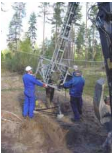
Bottensektionen av masten är snart på plats.
